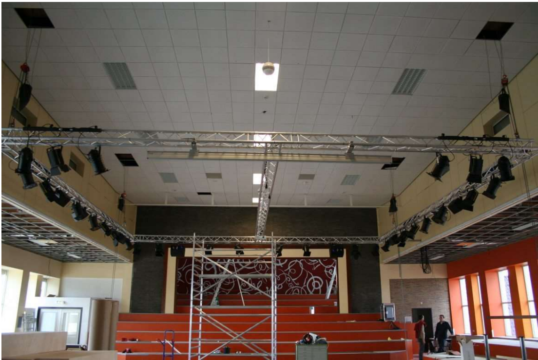
Aula Stedelijk Gymnasium
